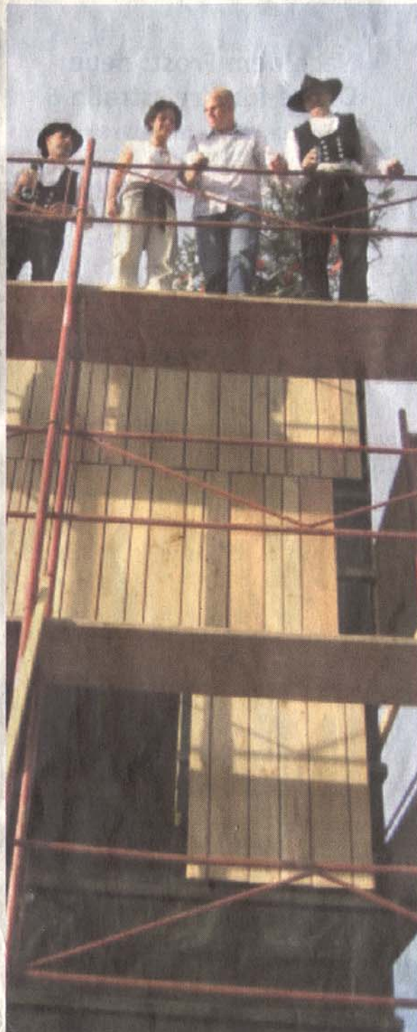
Handwerker aus Plettenberg beim Richtfest der neuen Thallessa-Freizeitanlagen-Zentrale in der Nähe von Innsbruck. Foto: Privat
