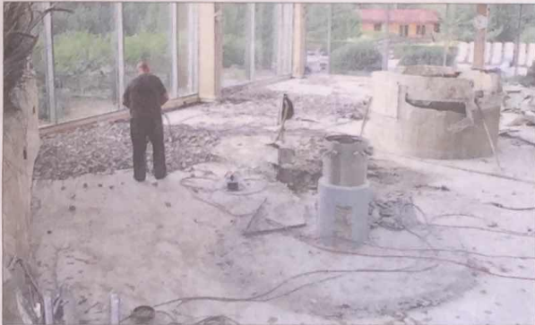
Presslufthammer dominieren derzeit das Bild im ehemaligen Saunabereich.
