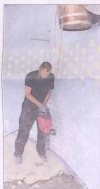
Im Duschbereich wird alles komplett erneuert.
